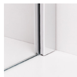
Fixglas in U-Profil montiert
