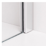
Fixglas in U-Profil montiert
